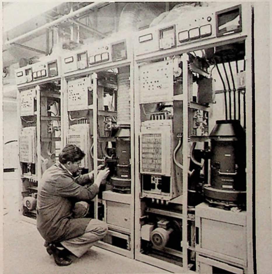
Montage van de 1,2 kW - eindtrap van de zender.
